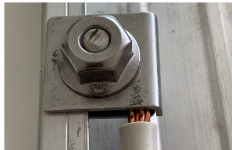
Anbindung Litzendraht an die Grundschiene Connection of stranded wire to the base trough
